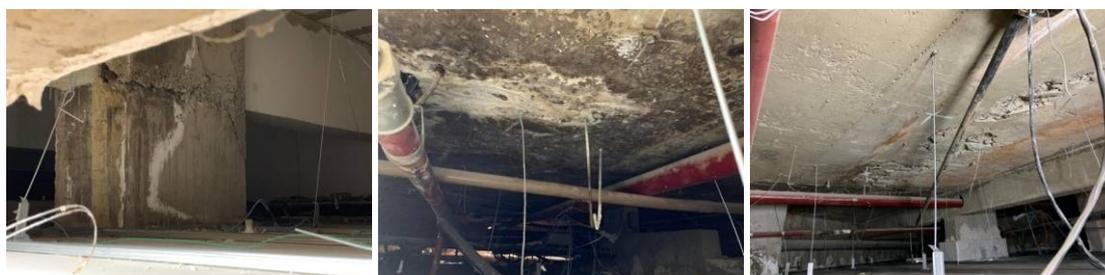
Fotos: Deterioração do concreto nas lajes sob os jardins internos.
