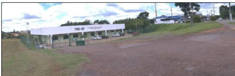
Foto 8: Vista externa do Cartório: local da construção do estacionamento.
