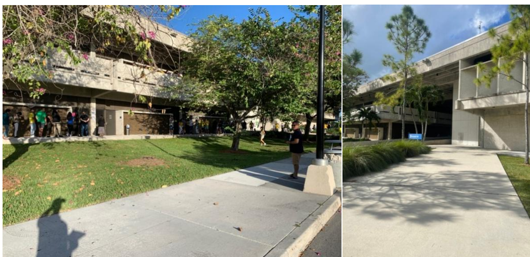
Fotos: Vista geral do Prédio 9.
